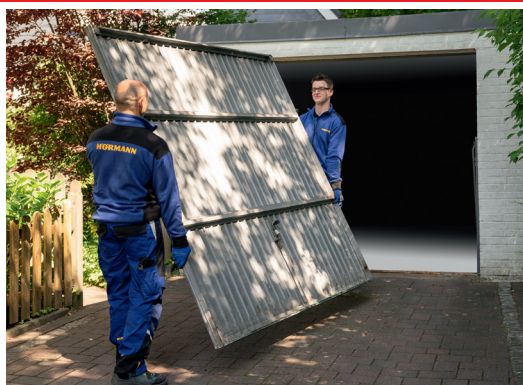
Ausbau und umweltgerechte Entsorgung
